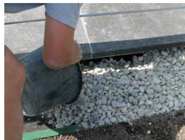
9. Füllen Sie die vegetationsfreien Zonen aus mit Kies.
