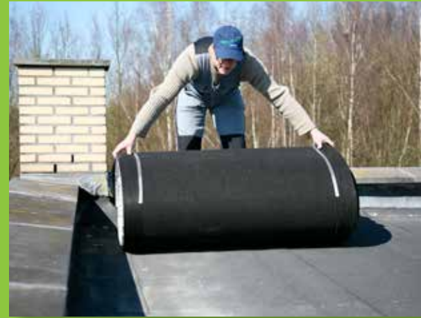
3. Positionieren Sie das ND Drainagesystem und Rollen Sie das System aus.
