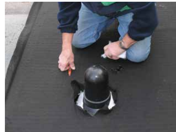
7. Schneiden Sie die Dachdurchdringungen aus.
