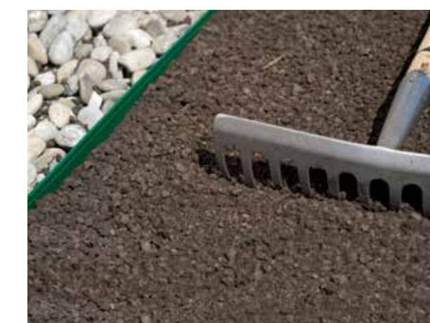
11. Verteilen Sie das ND Substrat gleichmäßig (5 - 8 cm Dicke).
