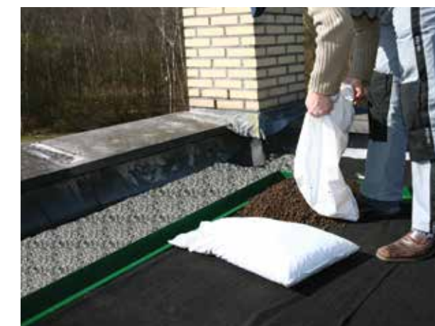
10. Leeren Sie die Säcke mit ND Substrat.
