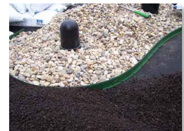
12. Rund um die Dachdurchdringungen sollten Vegetationsfreie Zonen gemacht werden.
