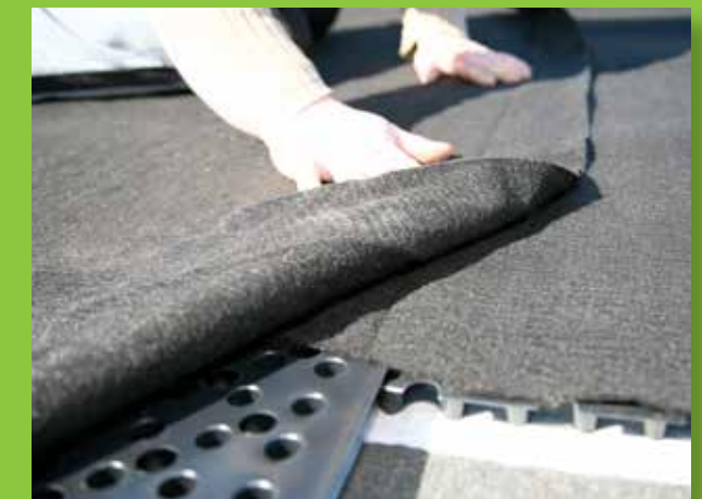
6. Lassen Sie die Filtergeotextile überlappen.
