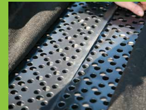
5. Platzieren Sie die ND Drainagesysteme gegen einander.
