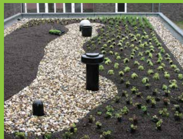
15. Das Gründach kurz nach der Installation.
