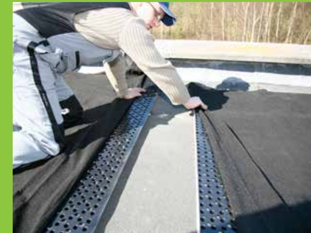
4. Platzieren Sie das nächste ND Drainagesystem.
