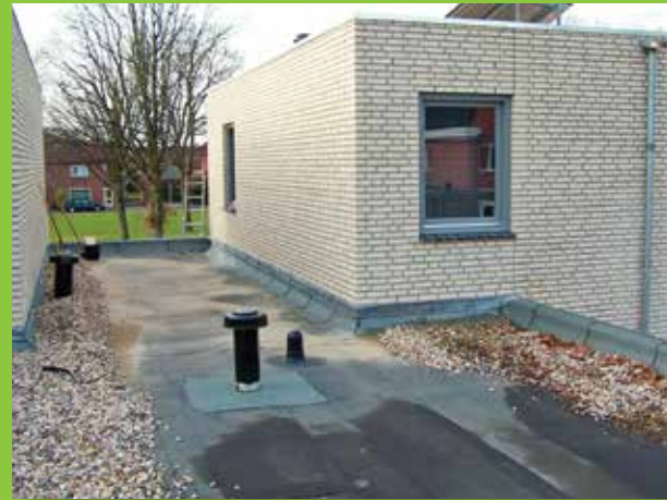
1. Die Ausgangssituation, ein 0°-Dach bis 2 % Gefälle*.
