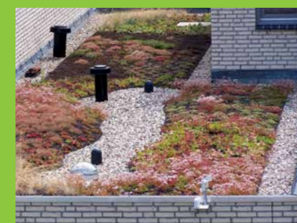
16. Das Dach einige Monate nach der Installation.
