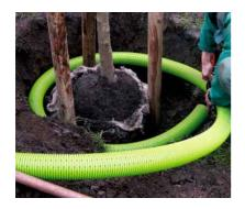
Das allseitig gelochte Baumerhaltungs-Rohr wird ringförmig im Wurzelbereich unter der Kronentraufe verlegt und mit dem T-Stück verbunden.
