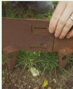
Nachdem Sie die Einfassungen oben verbunden haben, biegen Sie die Verriegelungslaschen unten mit einer Zange zur Seite. So werden die beiden Teile vollständig miteinander verbunden.
